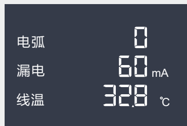
电弧0次 漏电60mA 线温32.8℃
